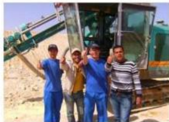
На строительстве скоростной железной дороги в Ливии
